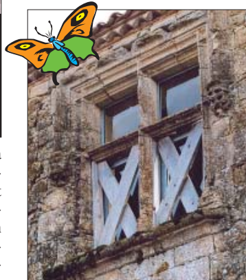
Grande croisée du château. Cette fenêtre est divisée par un meneau (vertical) et une traverse (horizontale) croisés. XV e -XVI e siècle.
