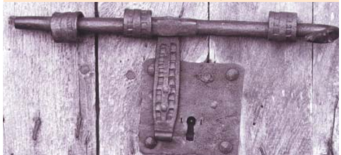
Prieuré de Serrabonne (Pyrénées Orientales) XII e siècle. Serrure à « plate », associée à un verrou à morailon. L'extrémité coudée s'orne d'une tête d'animal. Les vertevelles et le morailon sont ciselés au « bédane (6) », type de fermeture qui assurait les guichets pour piétons.
