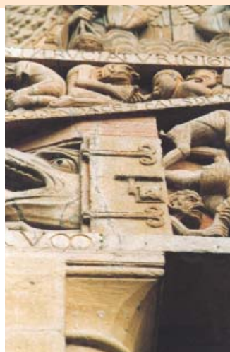
Eglise Abbatiale de Conques (Aveyron - XII e siècle). Détail de la sculpture du tympan représentant un ventail ouvert, ferré de deux pentures à cannelures et volutes et d'un verrou à morillon associé à une serrure à « bosse ».
