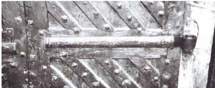
Cathédrale de Bayonne (Pyrénées Atlantiques) - XIV e siècle. Contreparement de vantaux à couverture de planches sur bâtis d'assemblage. On distingue les décharges obliques. la penture à branche droite, assujettie par des clous et des brides.
