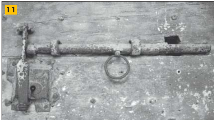
11 Eglise de Rozan (Gironde) - Verrou à vertevelles. Un morillon indépendant, associé à une serrure à bosse, permet de le condamner en position de fermeture (XIII e - XIV e )
