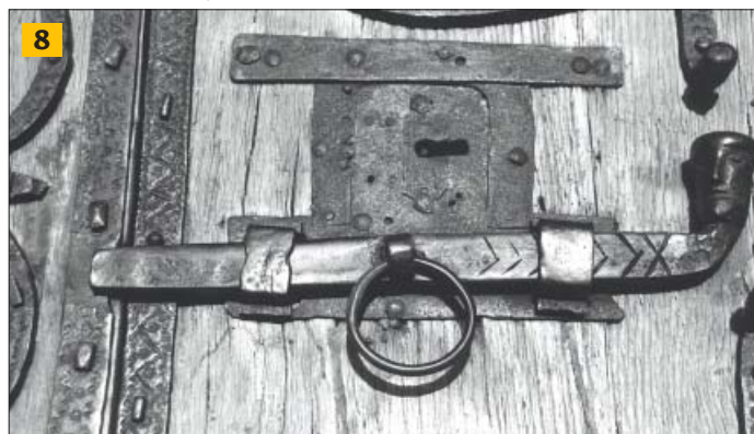
8 Eglise de Ligniac (Corrèze) - Serrure à vertevelles - Exemple le plus ancien que nous connaissons (XIII e )
