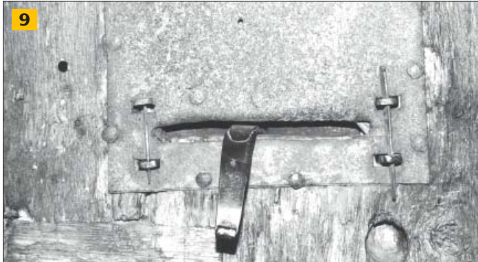
9 Eglise de Ligniac (Corrèze) - Revers de la serrure à vertevelles (photo 8). Nous apercevons la queue de manœuvre et la rainure de coulisse.
