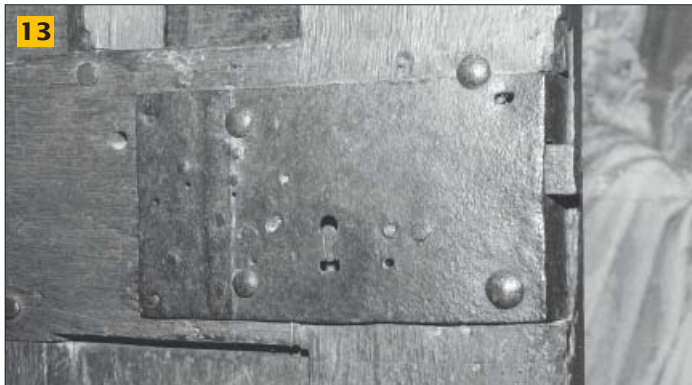
13 Château de Palluau (Indre) - Serrure à pêne dormant dont nous apercevons le pêne sorti de la tête (XV e )
