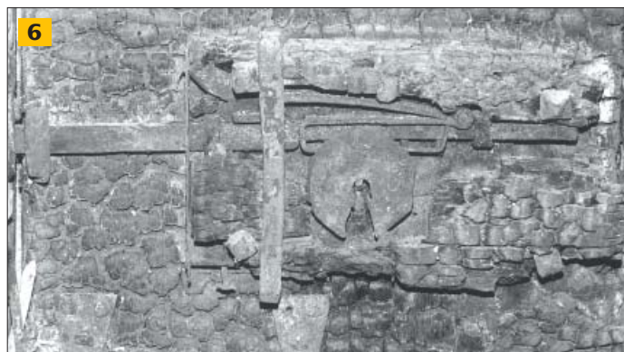
6 Cathédrale de Bourges (Cher) - Serrure à pêne dormant, à « cœur ouvert » après un incendie du coffre en bois (XV e )
