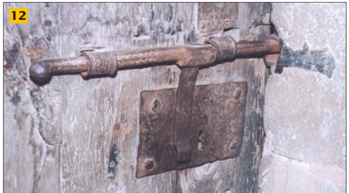
12 Eglise abbatiale de Conques (Aveyron) - Verrou à morillon et serrure à plate (XII e - XIII e )
