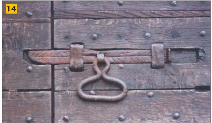
14 Maison de village à Saint Cirq Lapopie (Lot) - Verrou plat à balottière, réemployé sur une menuiserie récente (XIV e )
