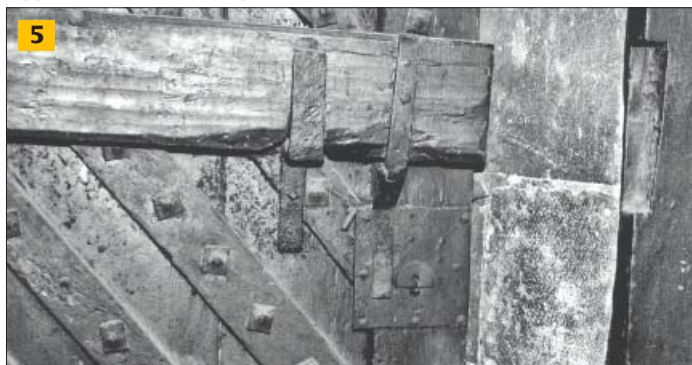
5 Cathédrale de Bayonne (Pyrénées Atlantiques) - Extrémité d'un fléau de bois en position de fermeture, moraillon indépendant, serrure à plate (XIII e - XIV e )
