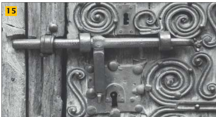
15 Eglise de Vinça (Pyrénées Orientales) - Bel exemple de verrou et serrure à plate caractéristique du XII e
