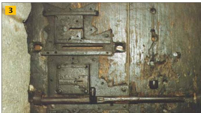
3 Eglise abbatiale d'Aubazine (Corrèze) - Deux serrures à vertevelles dont l'une a perdu son verrou. Remarquez la rainure de coulisse (XIV e ) (apposées sur un ventail plus ancien)
