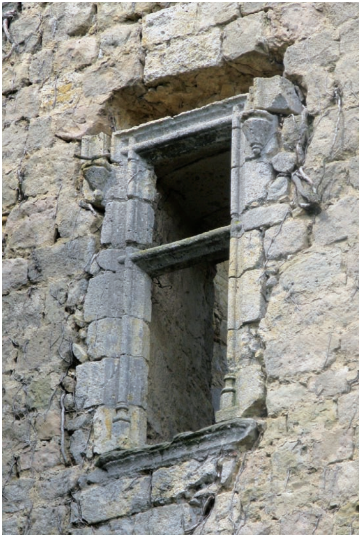
Demi-croisée ouverte lors des transformations du château.
