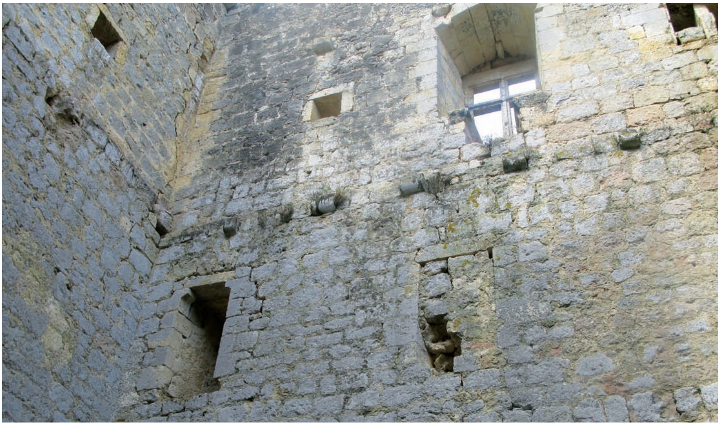
Les supports des planchers sont toujours en place entre chaque étage.
